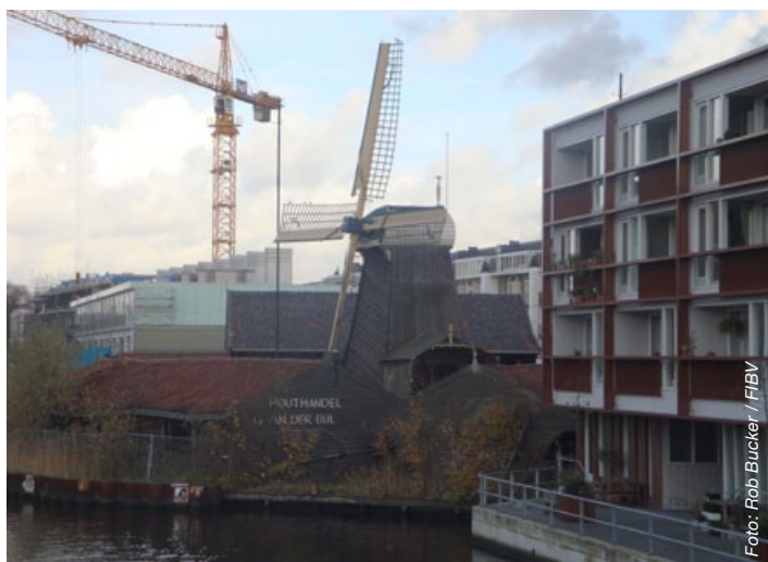
De molen en enkele nabijgelegen gebouwen vertonen verzakingsverschijnselen.
